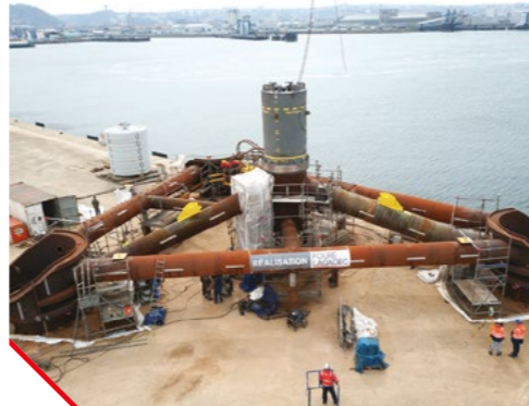
EMR : Fabrication tripode - support sous-marin de la turbine : 3 pieds, un mât central et 9 bracons. Cette structure triangulée hors normes mesure au sol 25 m par 30 m, pour une hauteur de près de 11m. La structure est désormais immergée par 40m sur un fond granitique au large des côtes bretonnes.
